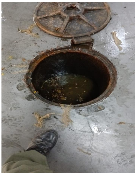
Limpeza das Caixas de Esgoto do Complexo SCCS
