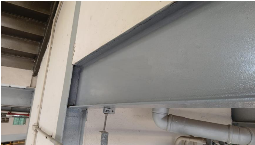
Preventiva e corretiva estrutura metálica.
