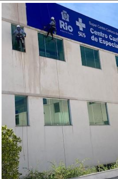
Limpeza Alta dos vidros e faixa da unidade
