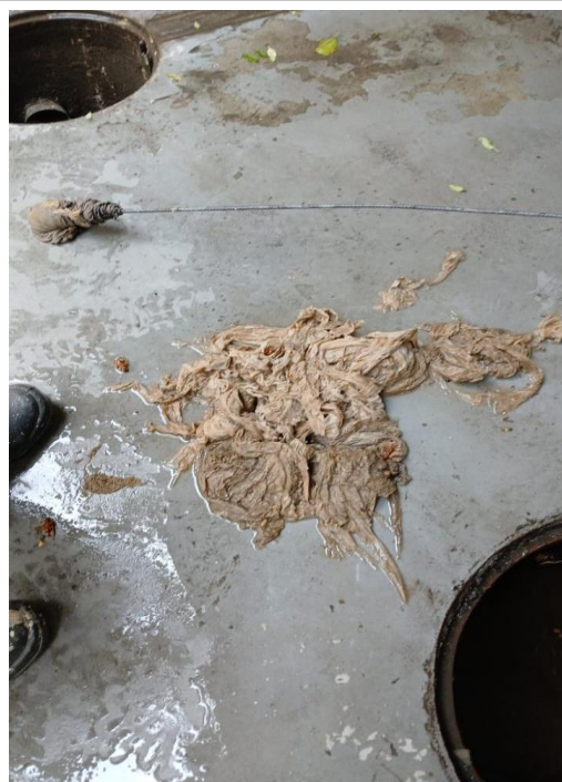
Limpeza das Caixas de Esgoto do Complexo SCCS
