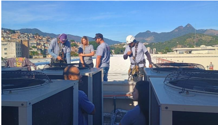
Limpeza Alta dos vidros e faixa da unidade
