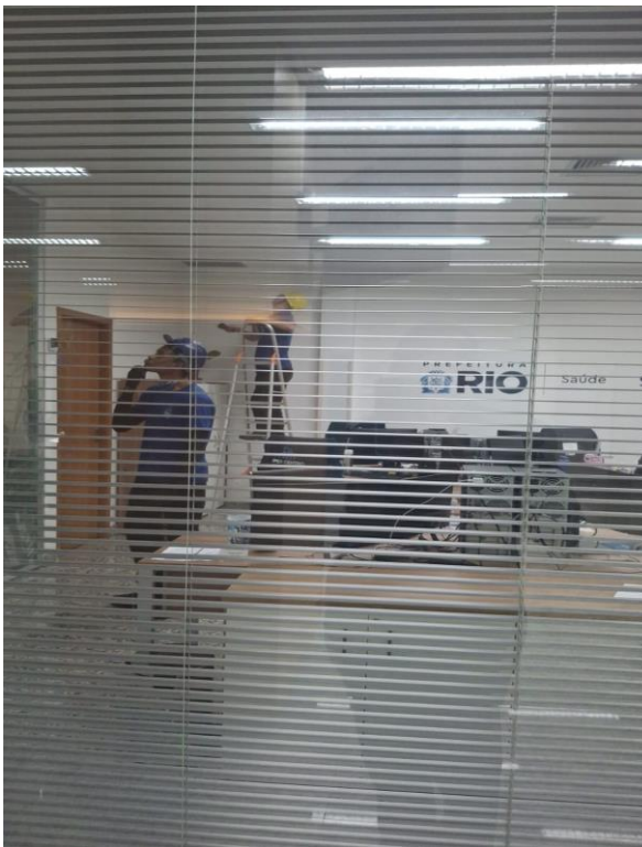
Limpeza dos DUTOS de Ar Condicionado
