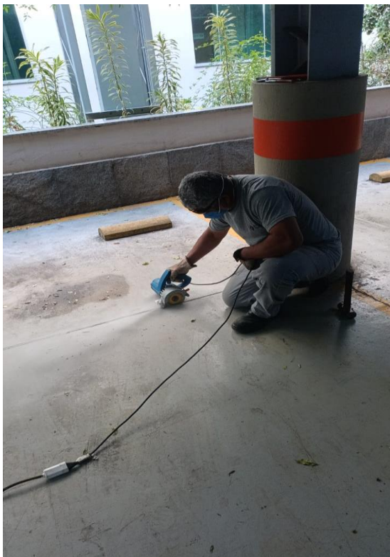
Preventiva e corretiva junta de dilatação do estacionamento.
