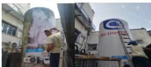
Relatório fotográfico limpeza tanque central.
