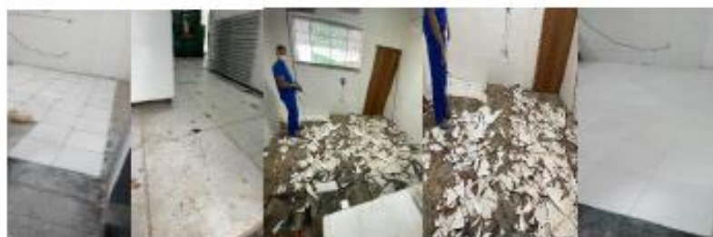
Relatório fotográfico substituição de piso depósito cozinha.
